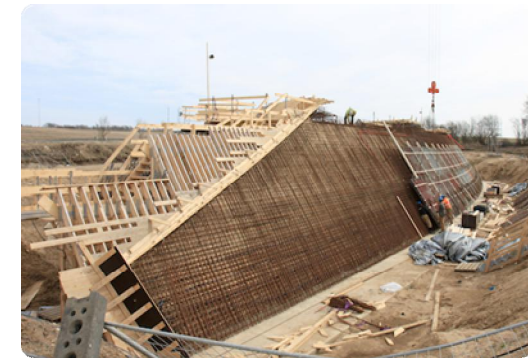
Insitu beton - Rammebro
