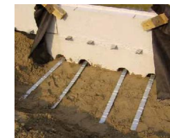
Reinforced Earth fløj vægge
