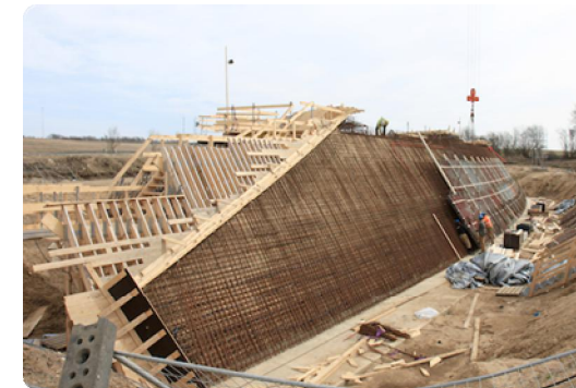
Insitu beton - Rammebro
